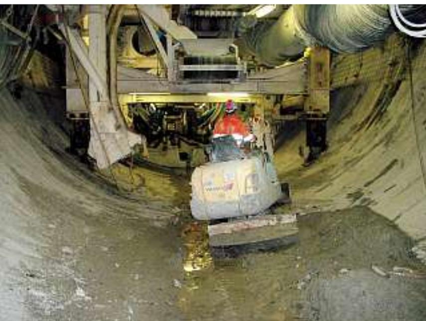
Illustr. 3: Travaux dans la zone de forage sous le tunnelier
