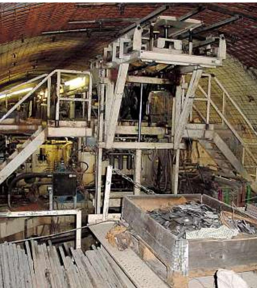
Illustr. 2: Travaux de coffrage dans un puits au-dessus d'un tunnelier.
