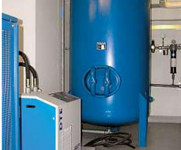
Réservoir à air comprimé avec déshumidificateur
